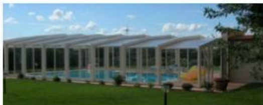
ESEMPIO DI COPERTURA TELESCOPICA
